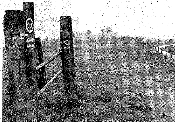
Der Rheindeich in Mündelheim: Ende 2010 könnten die Bauarbeiten für das 57-Mio-Euro-Projekt beginnen. Foto: Archiv, Foltin
