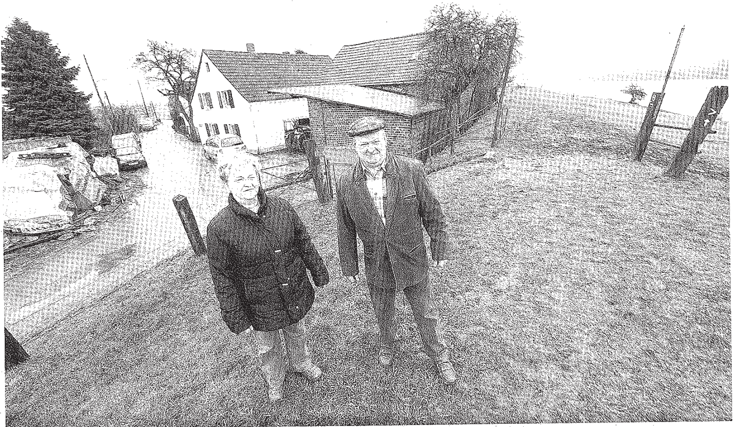
Heinz Höffges und seine Frau Inge auf dem Deich in Rheinheim . Unten am Fuß liegt der Hof des Ehepaares, der der Deichsanierung zum Opfer fallen wird. Damit geht für die Höffges mehr als ein Stück Heimat verloren . RP-ARCHIVFOTO: ANDREAS PROBST
