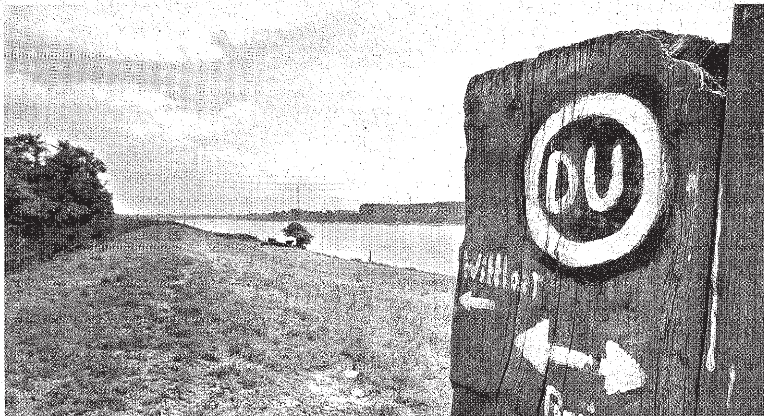
So sieht der Deich im Sommer bei Rheinheim, südlich von Mündelheim und Serm, aus. Hier entsteht komplett ein Neubau.
