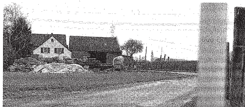
Die Gebäude stehen direkt am Deich. Der neue Deich wird höher und bekommt einen breiteren Fuß. Da ist der Hof im Weg.
