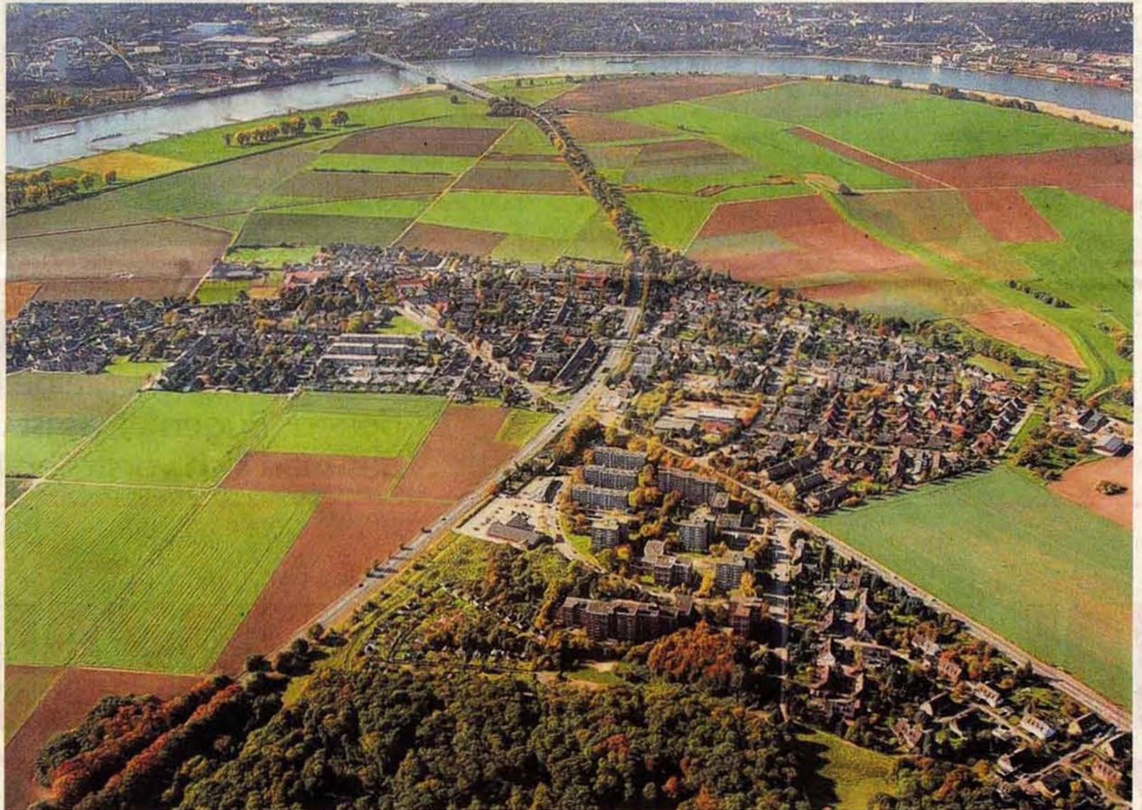
Die Aufnahme der B 288, von Osten her gesehen, zeigt die Ausbaustrecke auf Duisburger Gebiet bis zum Rhein. Sie macht aber auch anschaulich, in welchem Maß die Fernstraße heute Mündelheim zerschneidet. Luftbilder (2): Hans Blosssey
