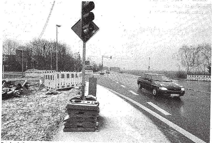
Provisorische Ampeln wie diese zeugen zur Zeit von den Umbauten im Kreuzungsbereich in Mündelheim. Nach Ansicht der Behörden die zu hohe Geschwindigkeit dort keine maßgebliche Unfallursache.
