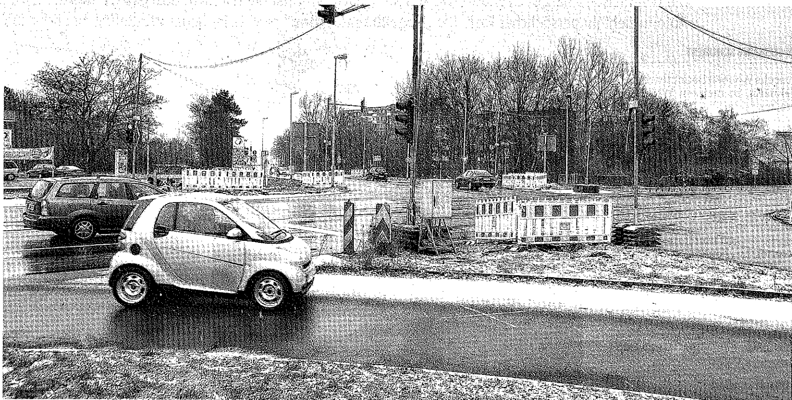
Viel Aufwand wurde getrieben, um die Kreuzung Uerdinger Straße / B 288 in Mündelheim mit einer Linksabbiegerampel auszustatten. Lange Zeit glich sie einer Großbaustelle. Doch ob sich diese Maßnahme positiv ausgewirkt hat, das bezweifeln viele Anwohner und Mündelheimer. RP-ARCHIVFOTO: ANDREAS PROBST
