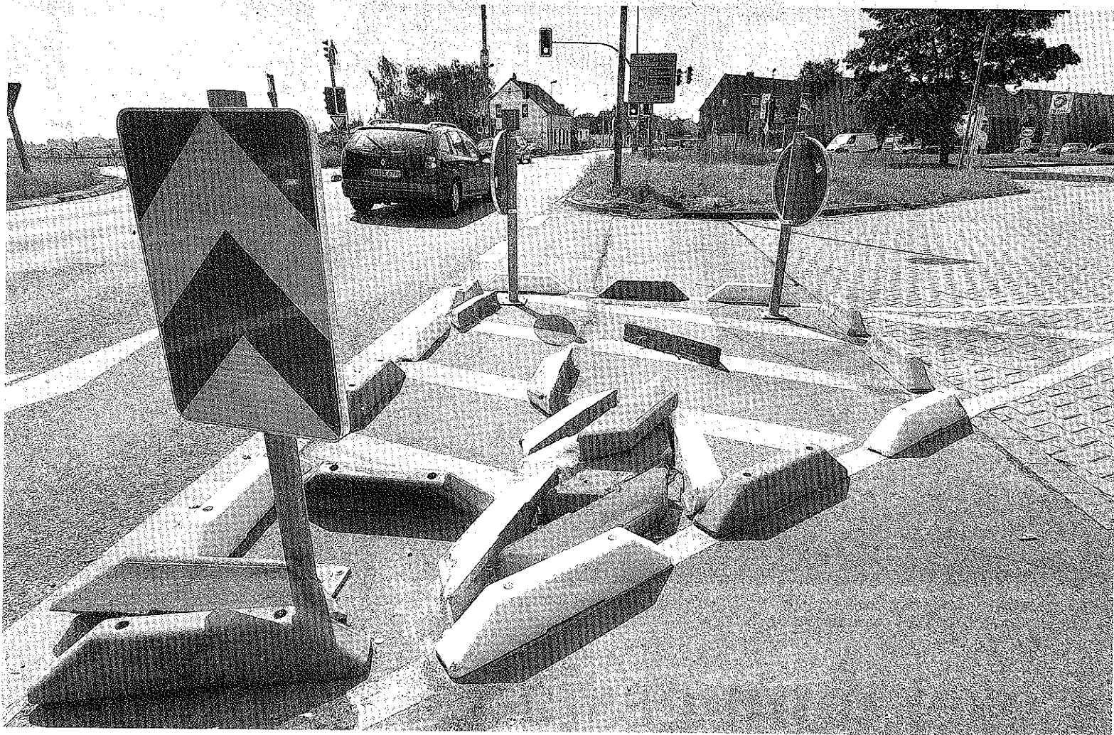
Diese Verkehrsinsel sollte den Verkehr von und aus dem Gelände der Tankstelle an der Kreuzung der B288 zur Uerdinger Straße besser regeln. Doch die „Fahrbahnsteine“ stehen nicht mehr. Nun wird eine neue Lösung gesucht.
