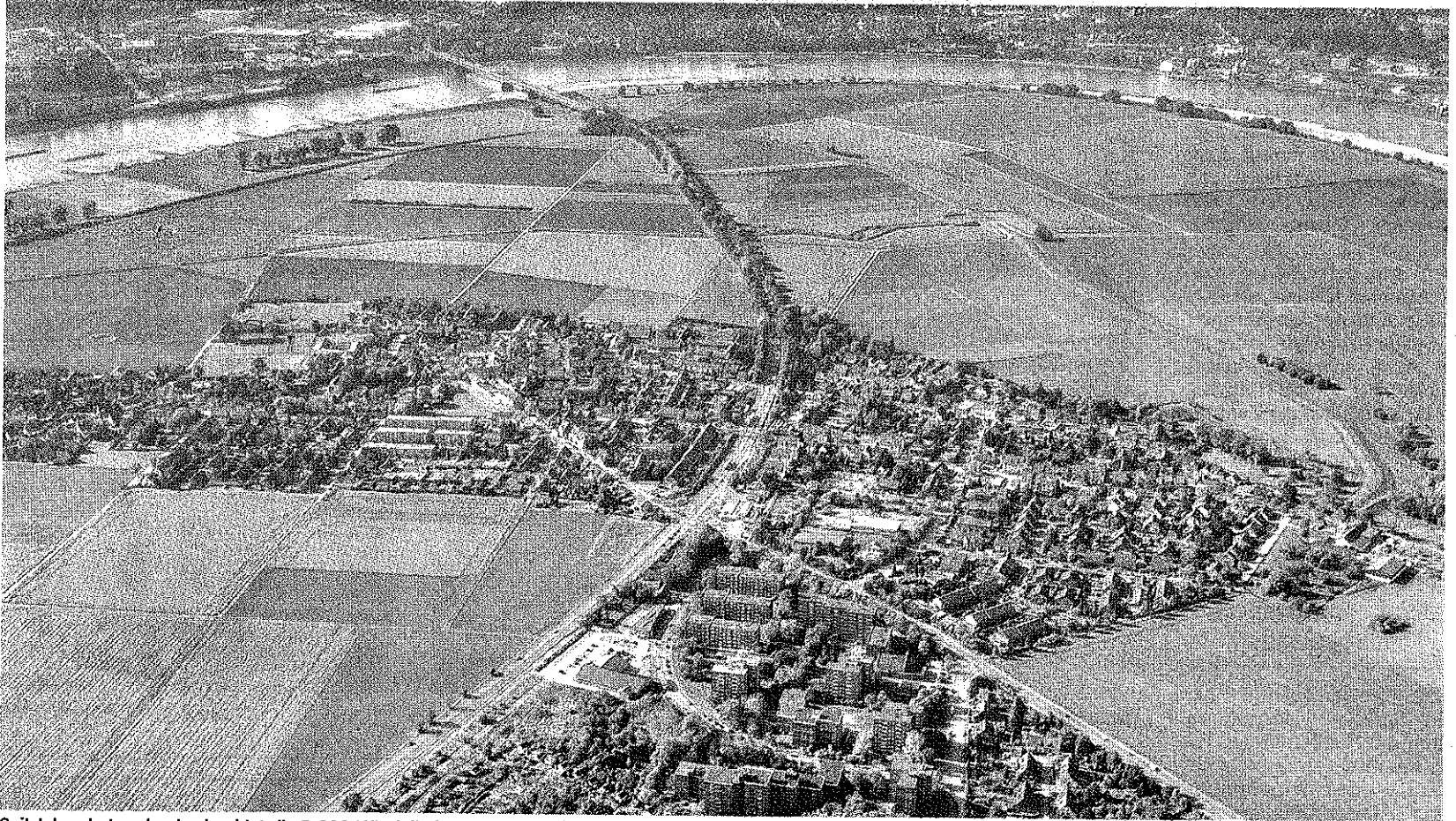
Seit Jahrzehnten durchschneidet die B 288 Mündelheim. Erst ihre Tieferlegung und Deckelung würden daran etwas ändern.
