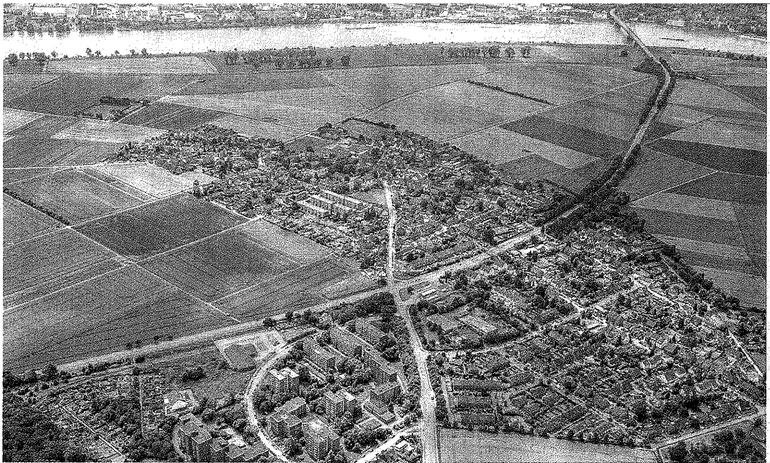
Unser Luftbild zeigt, abgesehen vom „Mannesmann-Acker“, der links vom Bildrand liegt, die neuralgischen Punkte beim Ausbau der B 288 zur Autobahn bei Mündelheim: die Kreuzung mit der Uerdinger Straße und die Uerdinger Rheinbrücke im Hintergrund.
